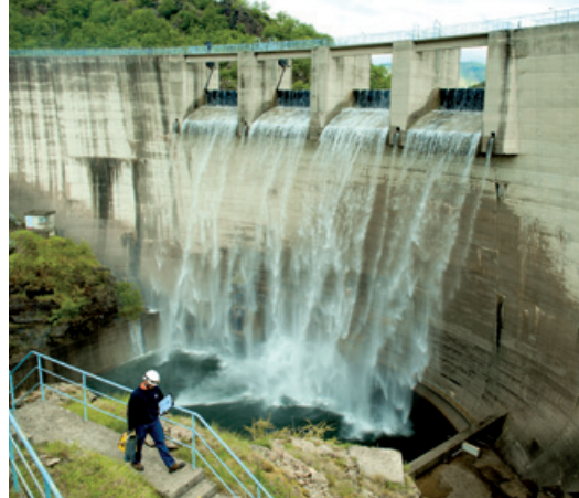
Barrage de Roujanel
